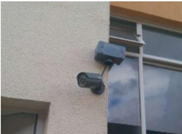
Esta câmera na entrada do prédio provê uma melhor identificação de pessoas que estão entrando e saindo do prédio. Posicionada a uma altura e distância adequadas, boas câmeras com infravermelho são capazes de gravar a qualquer momento do dia, mesmo com iluminação zero, qualquer indivíduo. A correta escolha da câmera para os mais diversos tipos de situação, bem como seu posicionamento é crucial para a identificação de ocorrências como roubos ou furtos.
