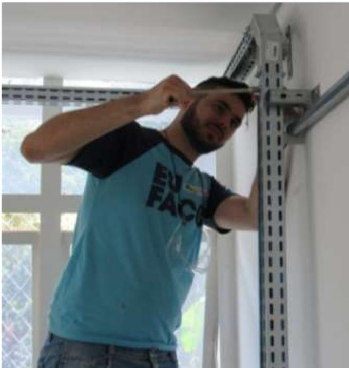
Instalação de eletrodutos, eletrocalhas, perfilados, canaletas, leito de cabos, piso elevado e qualquer tipo de infraestrutura para a passagem do cabeamento.
